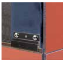
OFFENE ECKFUGE MIT EPDM BAND Bild 2
